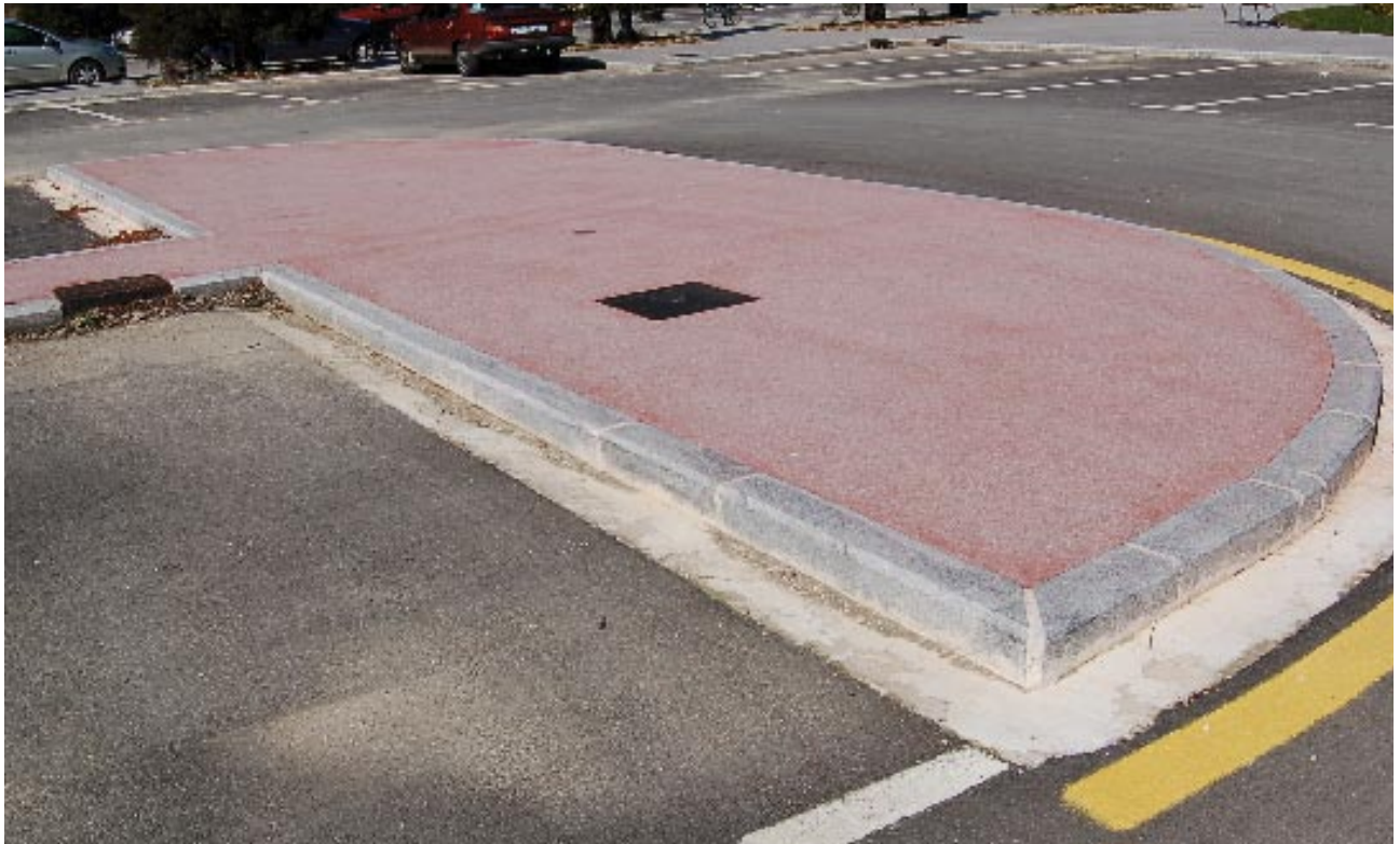
Asfalto fundido utilizado en el pavimento de un aparcamiento
