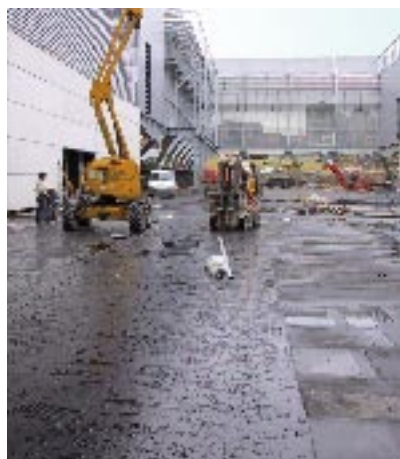
Maquinaria durante las obras
