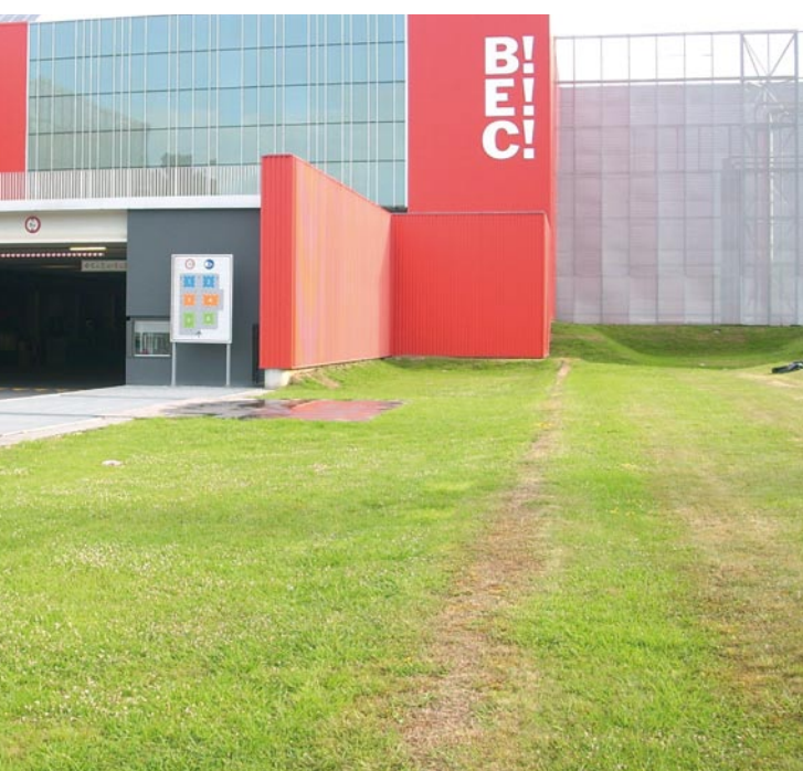
En el BEC se impermeabilizó una superficie de 14.000 m 2
